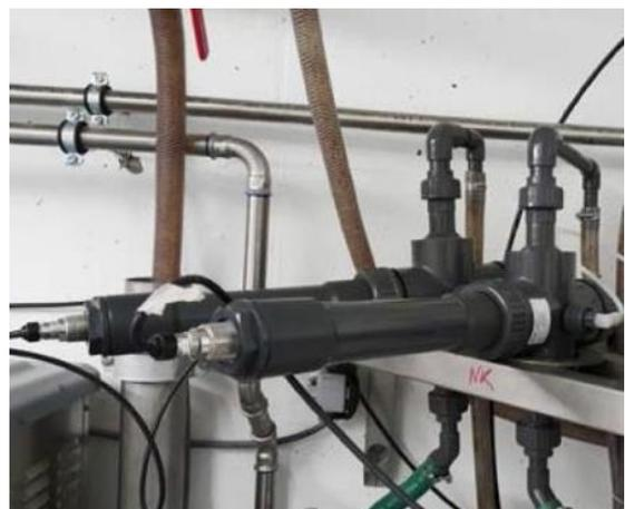
Abbildung 11: UV-Sonde mit Durchflussarmatur [14]
